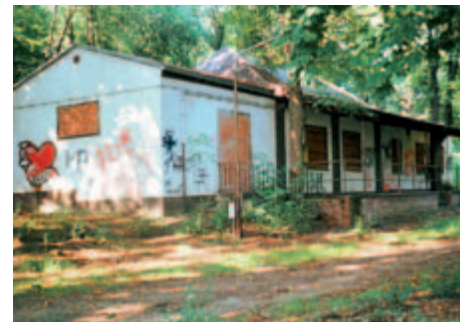
Zustand 1995 vor dem Abriss
